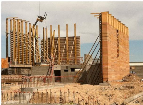
Рис. 2. Возведение стен по технологии SIREWALL
