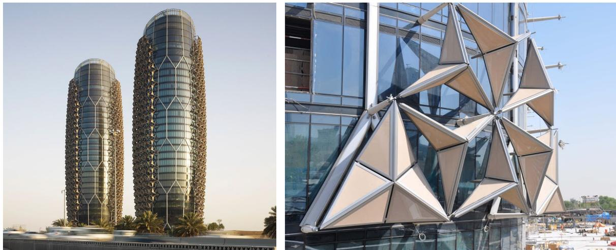
Рис.3. Башни Аль-Бахар и модули-зонтики расположенные на фасаде
